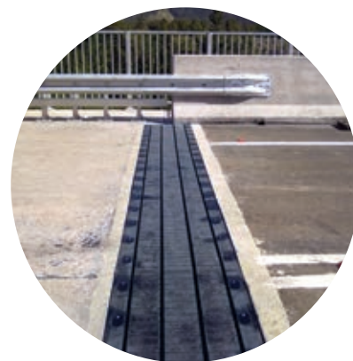
Figura 1.84 Para evitar que algunos puentes se deformen o se rompan, se colocan separaciones entre los bloques que los conforman.
